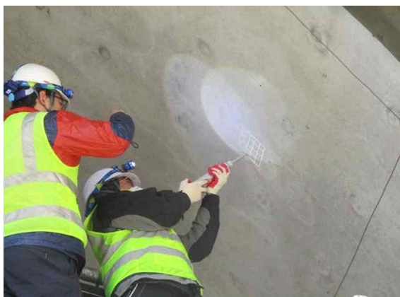
반발경도 측정 현황(천단부)
