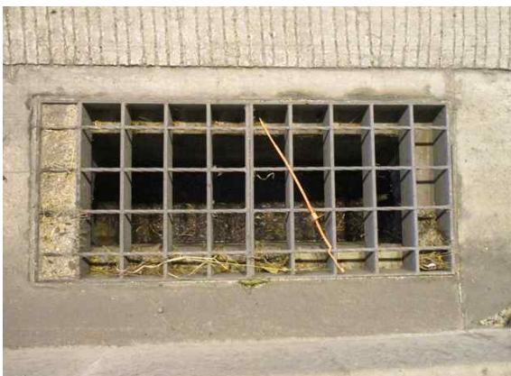
배수시설 집수구 전경
