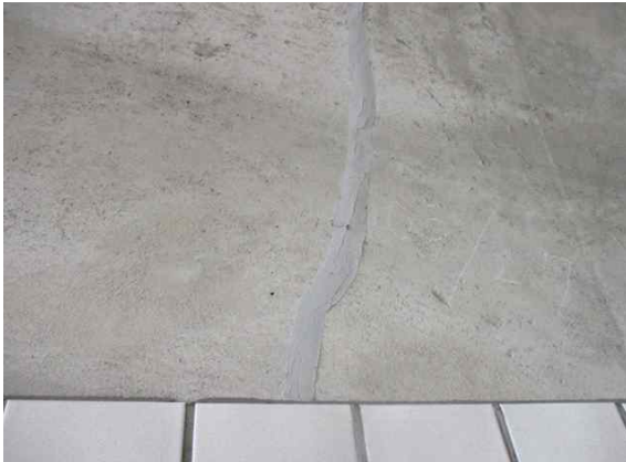
라이닝 SPAN.8 측벽부 균열보수현황
