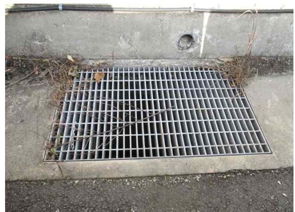
배수시설 집수구 상태양호
