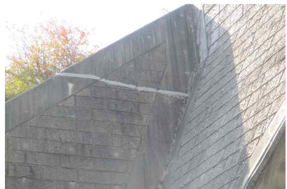
종점부 옹벽 균열부 백태 보수현황
