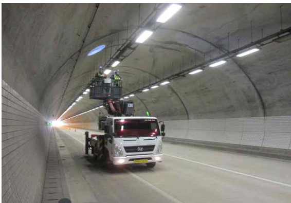
고소작업차를 이용한 외관조사 현황③
