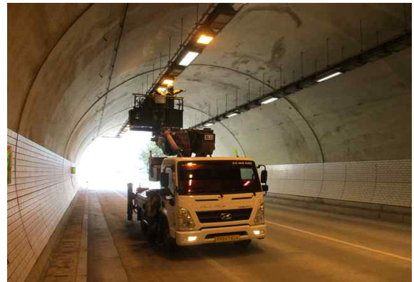
고소작업차를 이용한 외관조사 현황②
