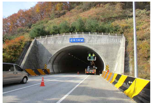
고소작업차를 이용한 외관조사 현황(갱문)
