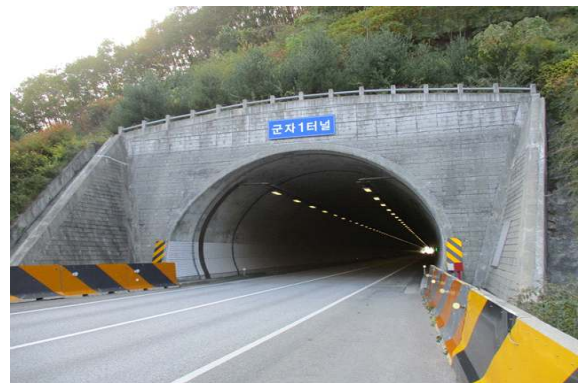
종점부 갯문 전경
