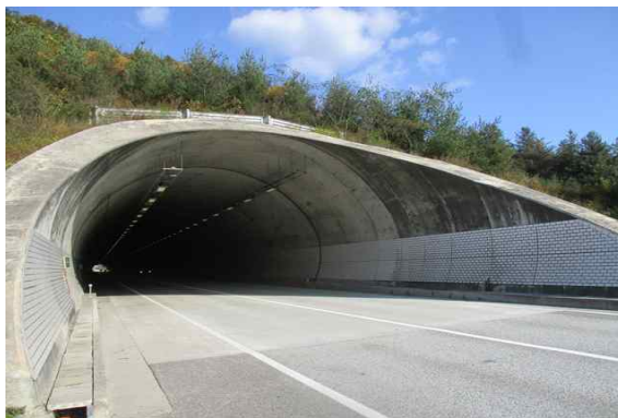
시점부 갯문 전경
