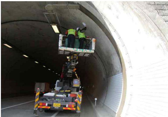
고소작업차를 이용한 외관조사 현황①
