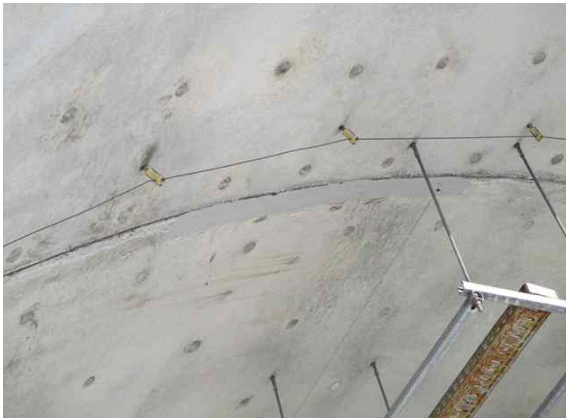
라이닝 SPAN.2 조인트부 박리 보수현황
