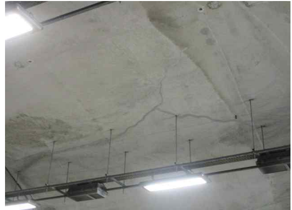
라이닝 SPAN.9 천단부 균열보수현황
