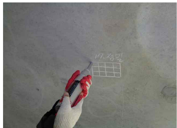
반발경도 측정 현황(측벽부)
