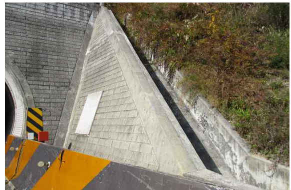
종점부 옹벽 전경
